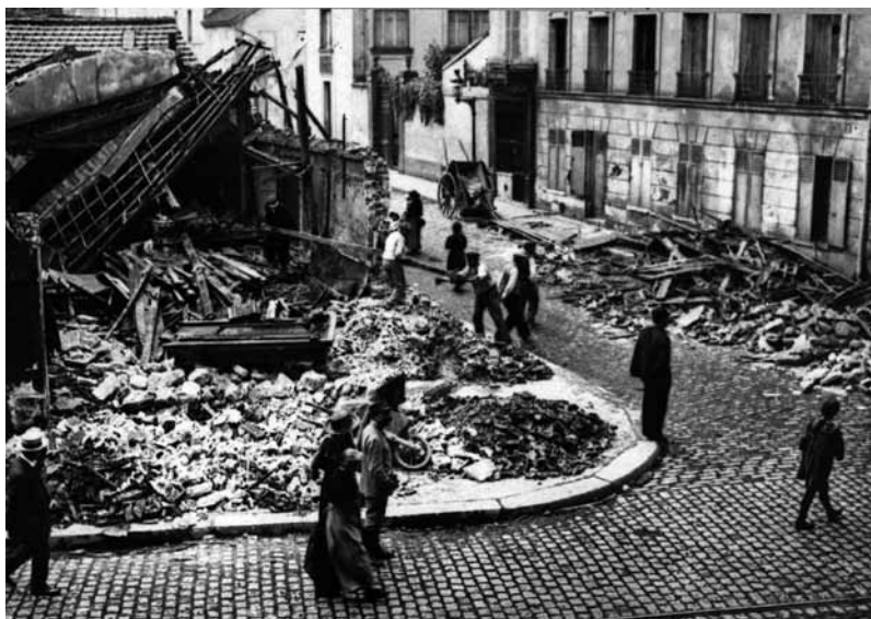
À Paris, ruines du n°353 bis de la rue de Vaugirard causées par les bombardements de la Grosse Bertha, 5 août 1918. BDIC : VAL 344/097.
