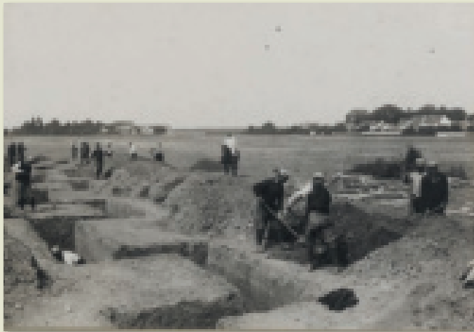
► Construction de tranchées par des territoriaux à Tigery, 1915. BDIC VAL 393_071.
