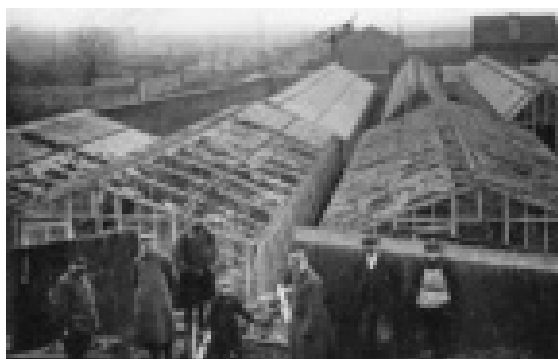
Les serres d'un horticulteur de Pierrefitte endommagées par un bombardement.
