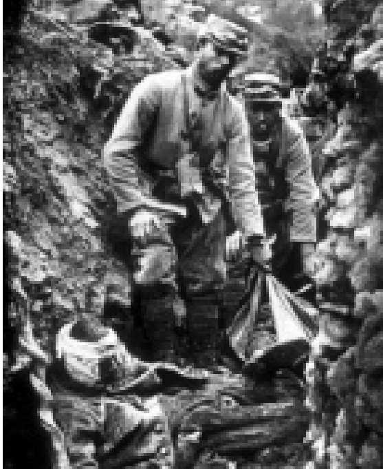
Tranchée de première ligne.
