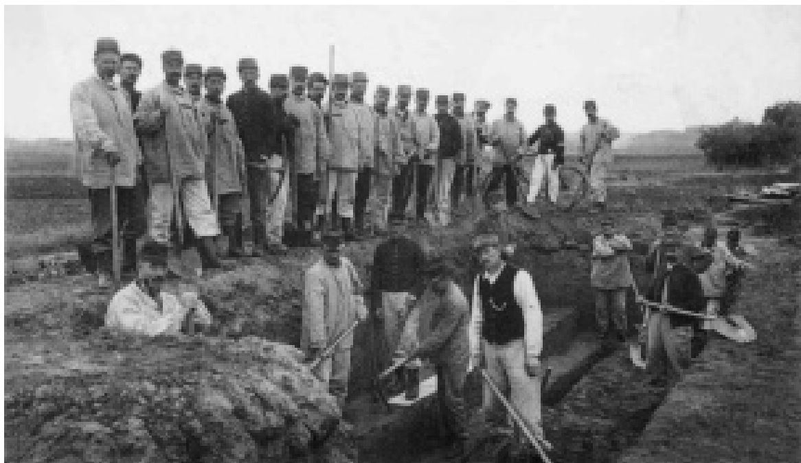
Creusement d'une tranchée à Villiers-le-Bel par une compagnie territoriale du génie, août 1914.
