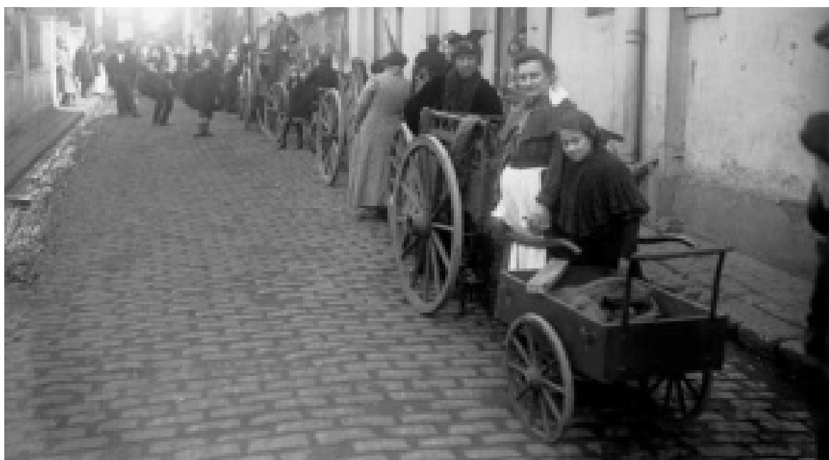
Distribution de charbon, 1916.
