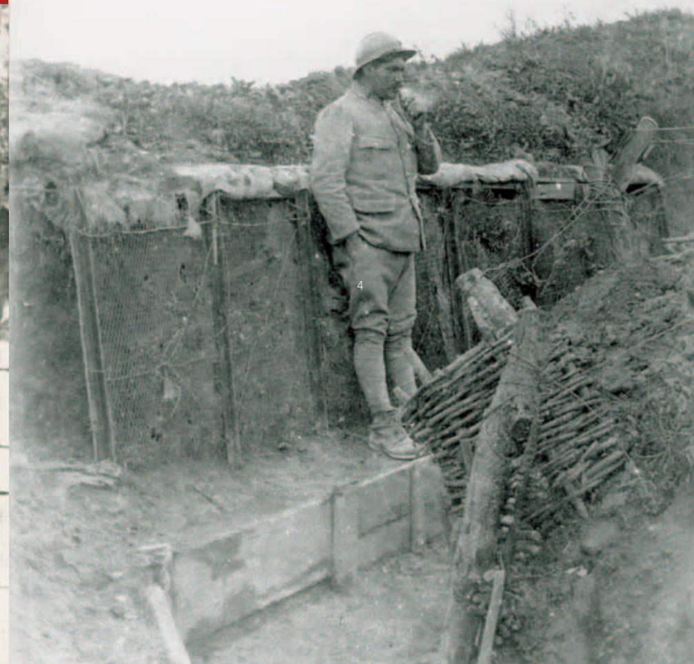
**3** Cette tranchée, c'est de la belle ouvrage. Du bien ordonné. Elle a deux niveaux. On s'y tient au sec. Les angles sont nets. La terre est fermement maintenue à l'extérieur par tout un dispositif de piquets, de grilles métalliques, de gabions, de coffrages en bois. Voilà qui par photo de presse interposée rassurerait tous ceux de l'arrière sur la solidité de nos positions. Voilà qui ferait dans les manuels techniques un excellent exemple pour tous ceux qui sont à l'instruction.
