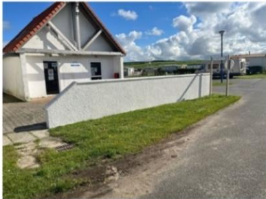
Remise en état des murets
